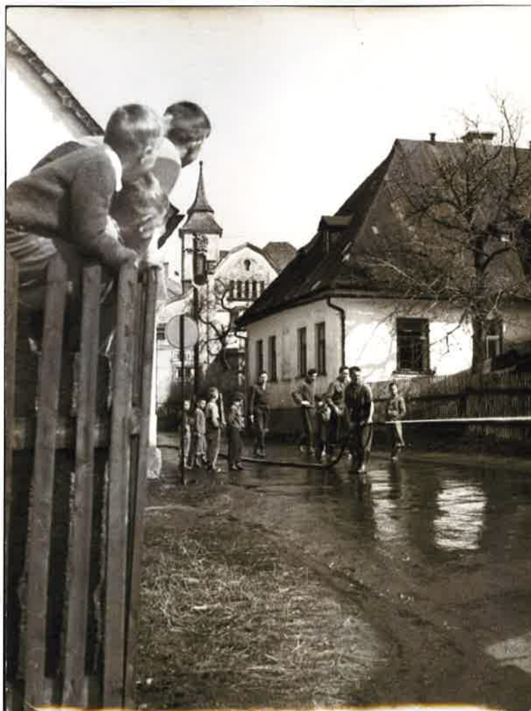
Vysočtí hasiči čistí stříkačkou ulici. Foto Jiří Vašíček
